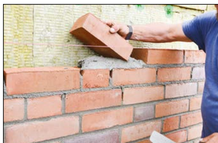
48 L'insertion en chantier.
